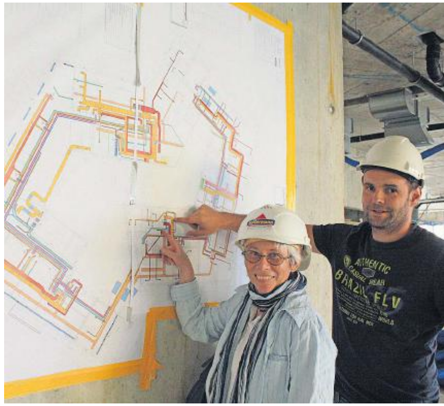
Bauleiter David Michel und AZOM-Verwaltungsratspräsidentin Heidi Berner studieren das Haustechnik-Verteilnetz.
